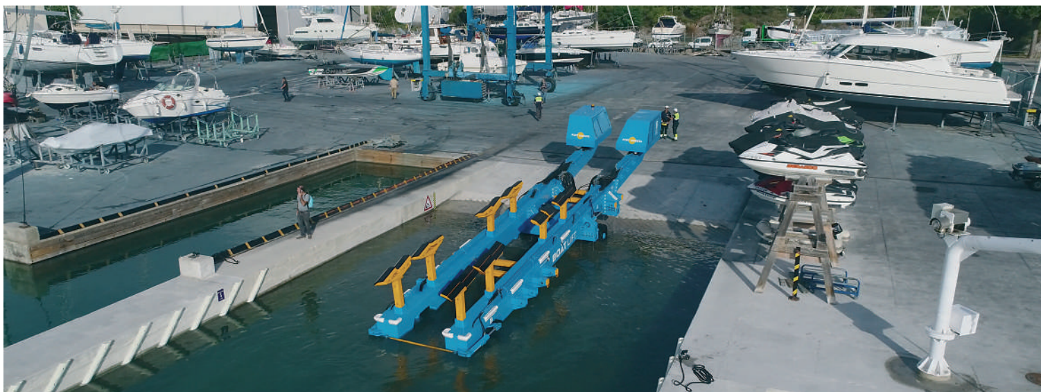
La nueva rampa del varadero permite sacar catamaranes de agua de hasta 12 metros de manga.
